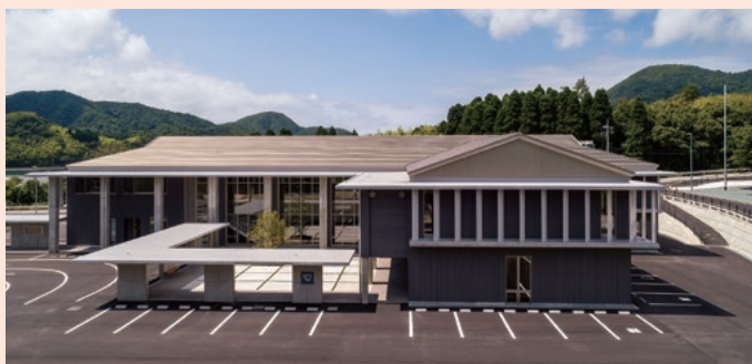
高台へ移転した西ノ島町役場
