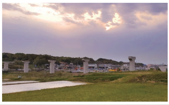
建設途中の山陰道
